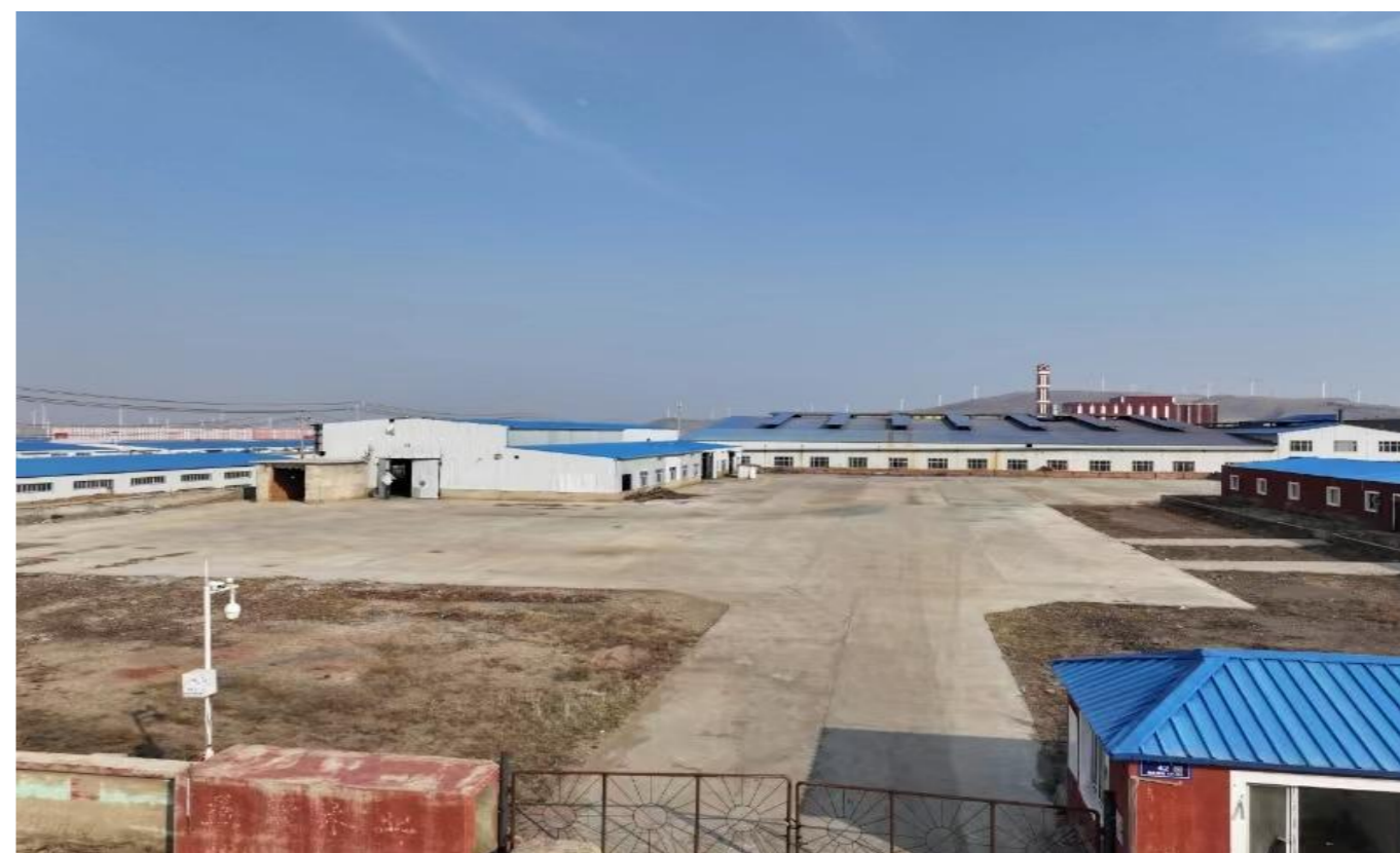
图 7-3 建筑垃圾处置及综合利用项目厂区现场图
